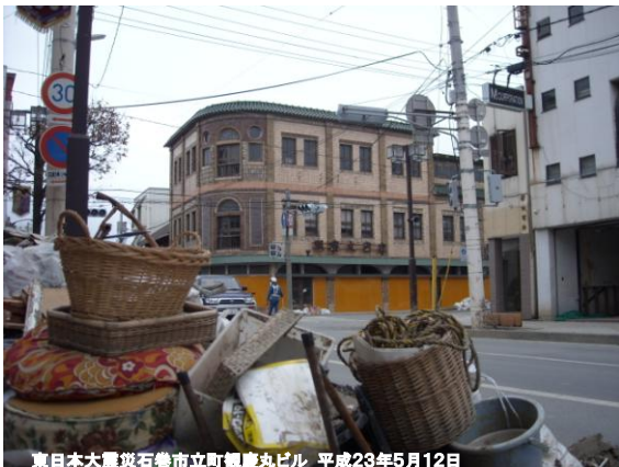
東日本大震災石巻市立町観音丸ビル 平成23年5月12日
