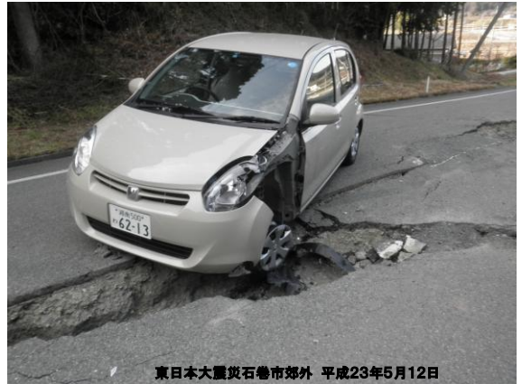
東日本大震災石巻市郊外 平成23年5月12日
