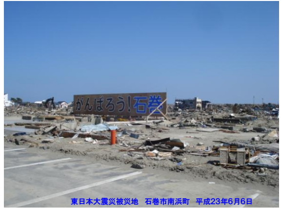
東日本大震災被災地 石巻市南浜町 平成23年6月6日
